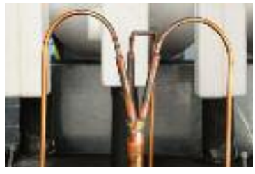
Kapillare Expansionsvorrichtung
