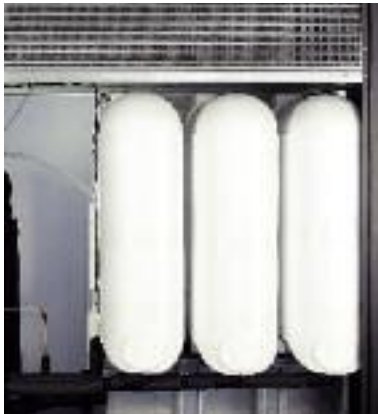
Wärmeschild-Isolierung mit umhülltem Einzel- oder Mehrfach-Wärmetauscher bietet hohe Wärmerückhaltung.
