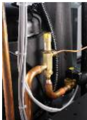
Heißgas-Bypass-Ventil
